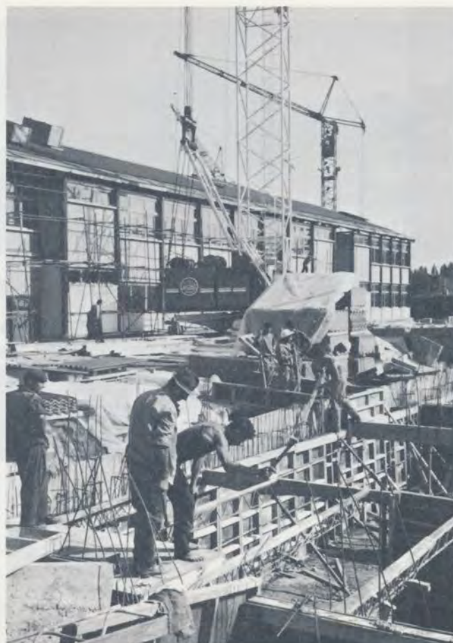
Arbeiten an der Ostfassade (Hauptfassade) des Gymnasium- Schulgebäudes
