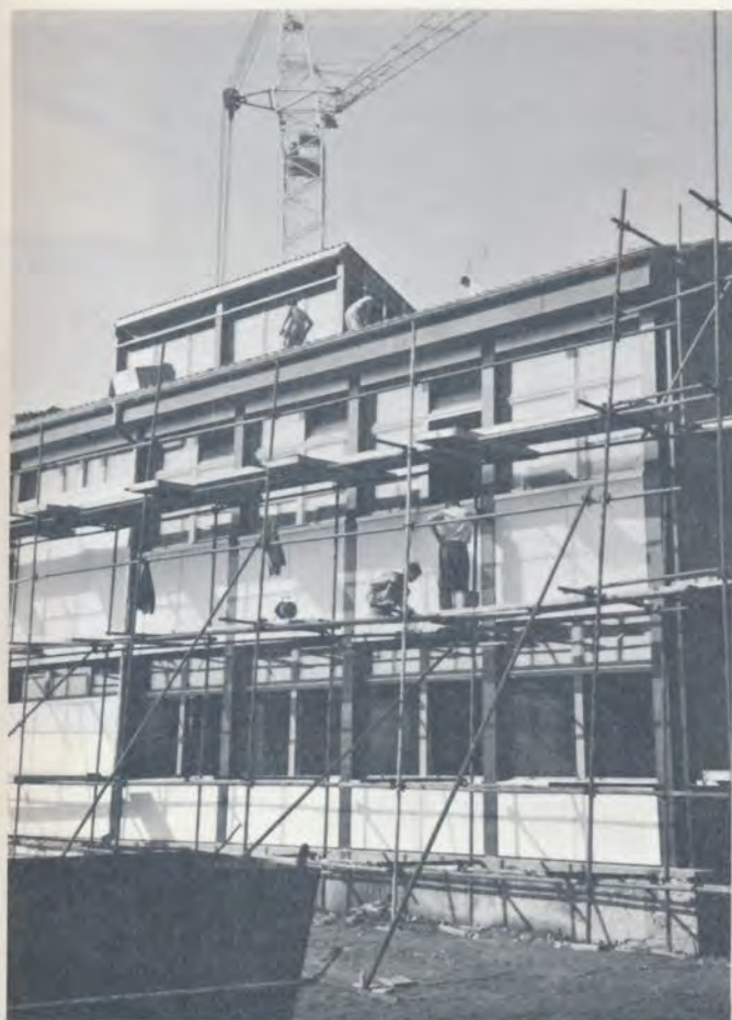
Westfassade des Hauptgebäudes und Turnhallenfundamente
