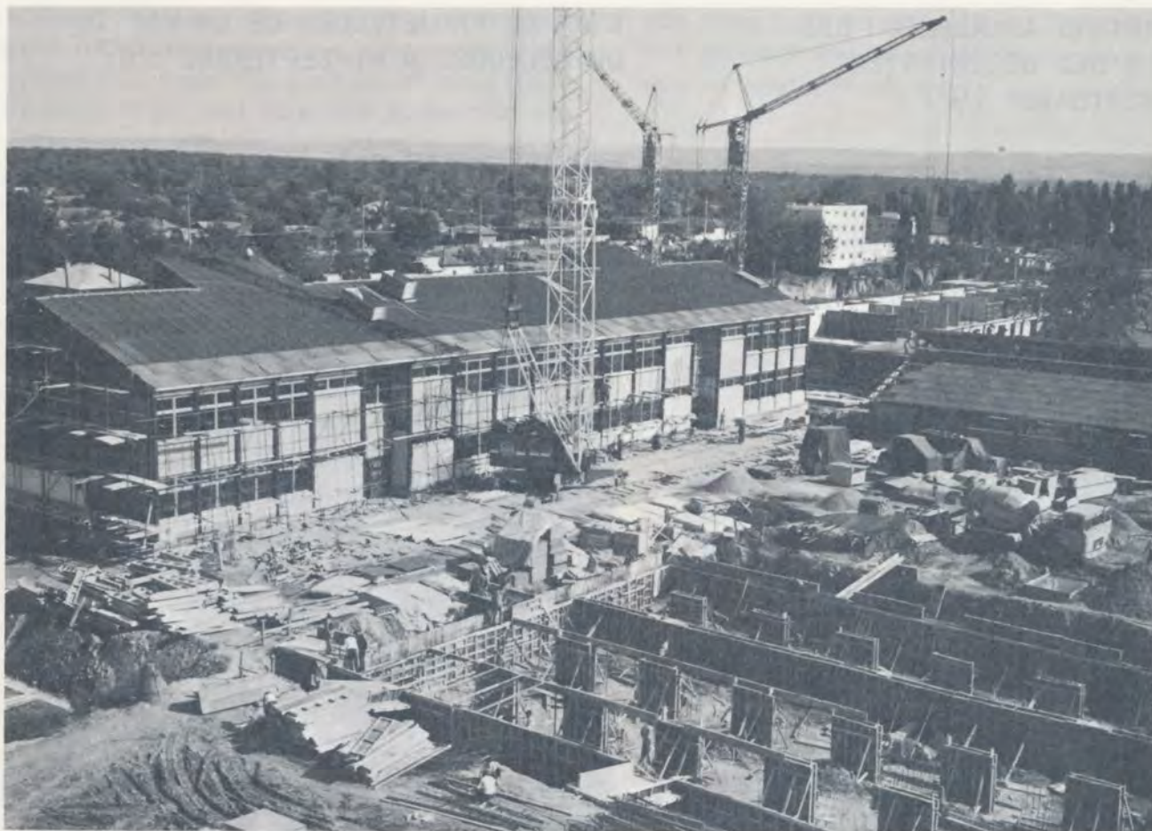
Ansicht der Baustelle: Gymnasium Hauptgebäude links, Werkstattgebäude rechts und Fundamentierungsarbeiten für Turnhalle im Vordergrund
