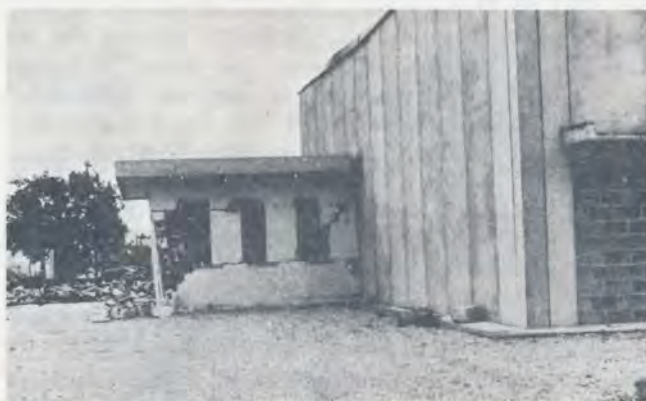
Bild 21. Vorfabrizierte Lagerhalle mit Backsteinanbau in Gemona. Tragskelett der Halle unbeschädigt. Steinwand bei Aufprall an steifen Anbau leicht eingedrückt. Dach des Anbaus durch die Impulsbelastung infolge ungenügender Fugenbreite abgeschert und weggeschoben
