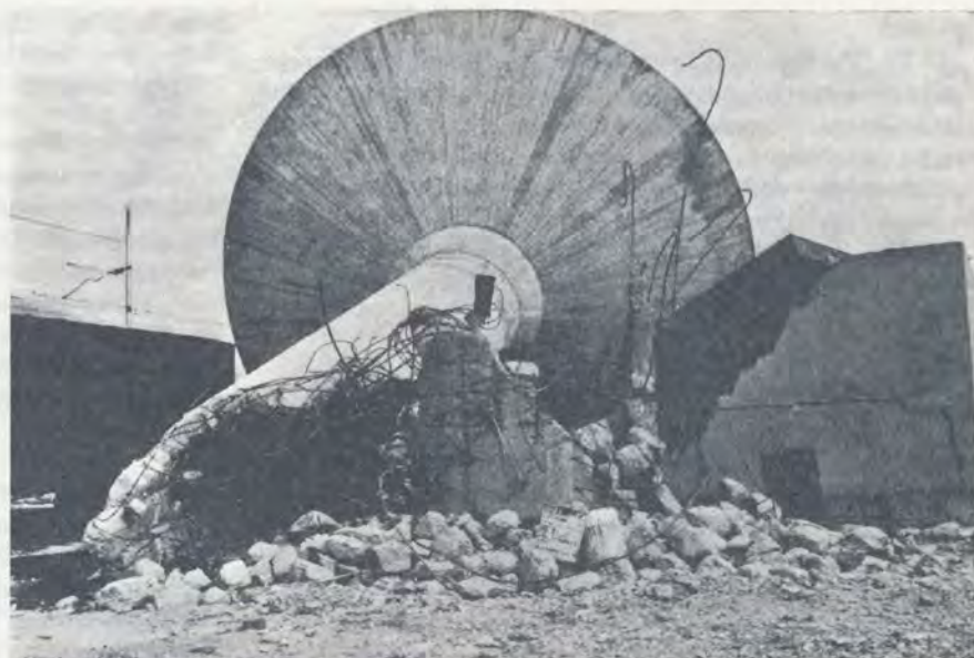
Bild 24. Umgekippter Wasserturm der italienischen Staatsbahnen im Bahnhof Gemona. Schafftuss auf eine Länge von 2 bis 3 Meter vollständig zerstört und Beton ausgebröckelt
