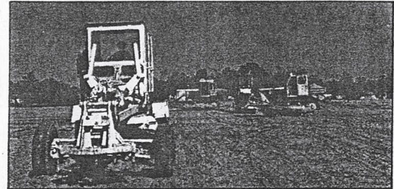
Công trình đường Bắc Thăng Long - Nội Bài. Vốn đầu tư 70 tỷ đồng Quy I đã thực hiện 15,7 tỷ đồng.
